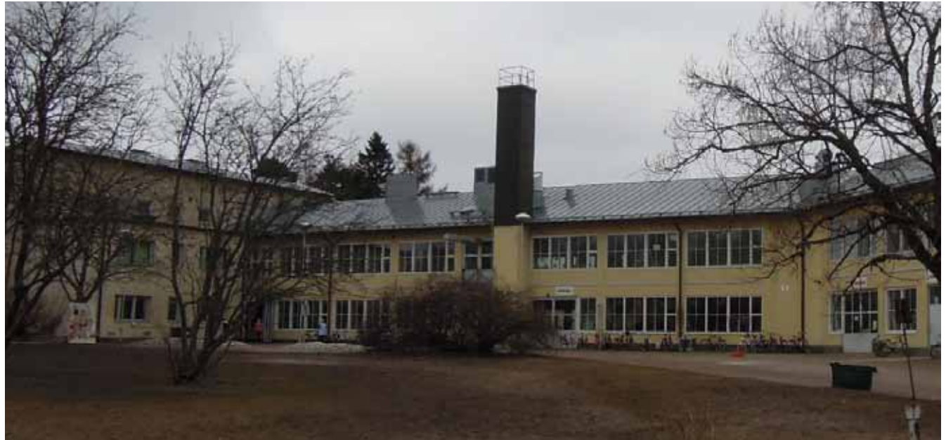
Julkisivu pihan suuntaan.
