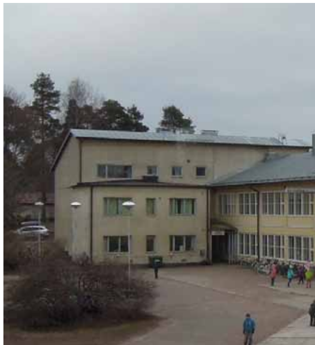
Luokkahuonesiipi pihan puolelta nähtynä. Edessä laajennusosa.
