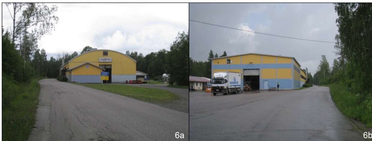
Kuva 6: Valssaamontie Lesjöforsin teollisuushallin kohdalla. Tie kulkee melkein hallin eteläseinustaa hipoen: kuvassa a tie on vasemmalla ja kuvassa b tie on oikealla.
