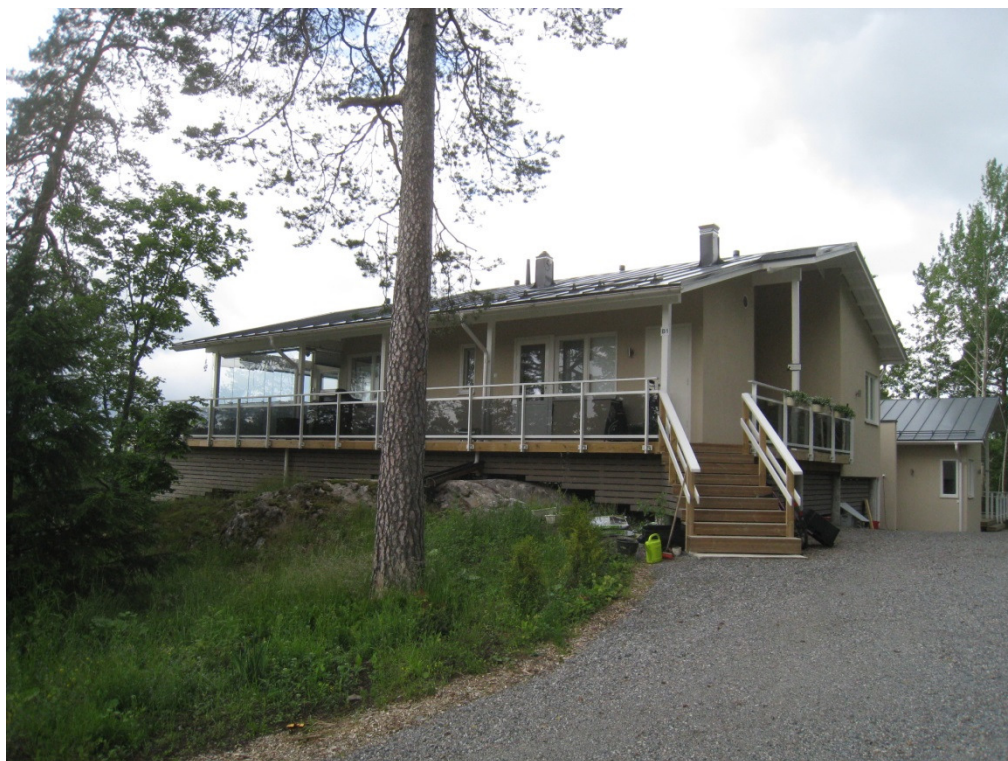
Kuva 5: Nykyistä rakennuskantaa: 8c.
