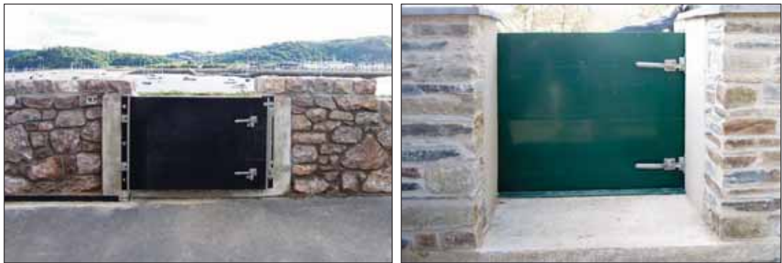
Kuva 10. Esimerkkejä tulvamuriin sijoitetusta tulvaportista. (Flood Control International 2019)
