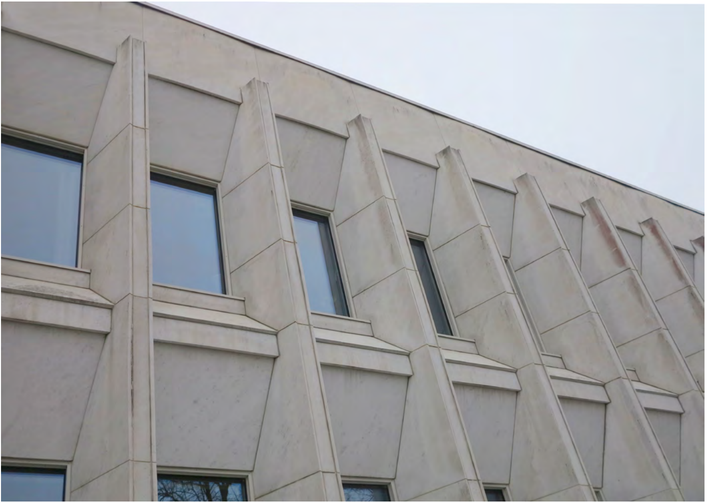
Fasadens karakteristiska material är Carraramarmor, mörkgrå granitsockel, bronshandtag i Aaltos design och huvudentréns kopparplåt. Foton Kristina Karlsson och Mona Schalin
