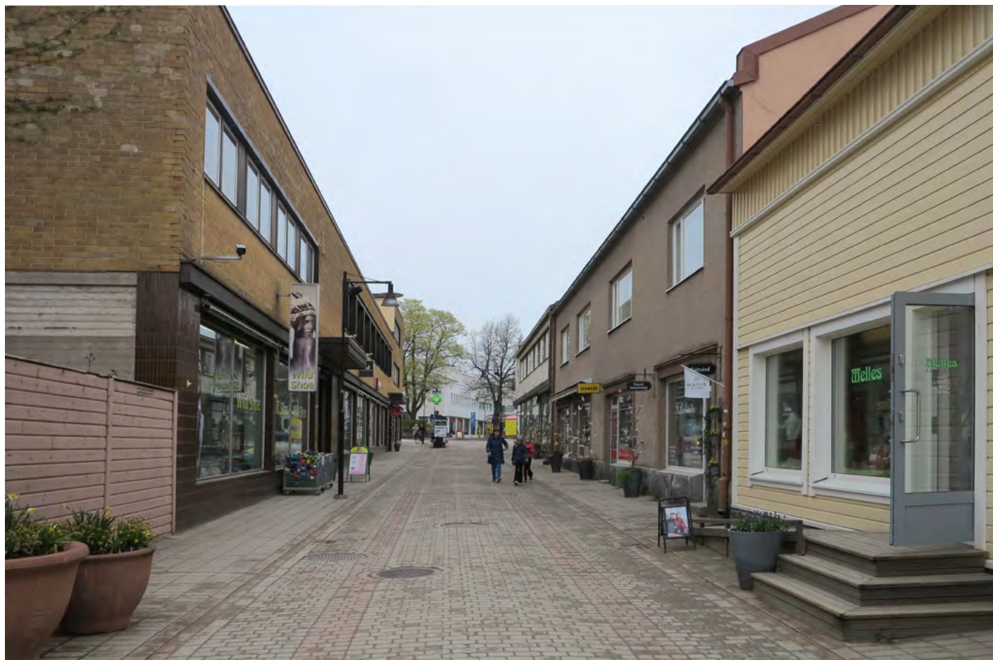
Utsikt längs Kungsgatan mot sparbanken. Byggnaderna i gathörnet vid Skillnadsgatan är utformade så, att gaturummet vidgar sig samtidigt som Kungsgatans riktning möter Stationsvägens gatulinje i en sned vinkel.
