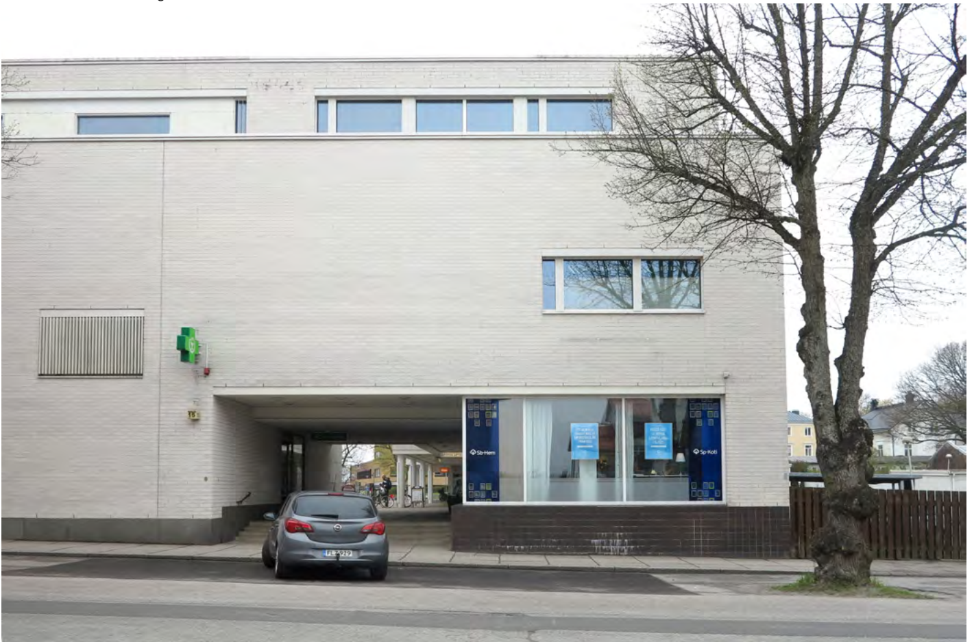
Portgång vid Ystadsgatan. Takvåningen är indragen från fasadlinjen också på gatusidan. Foto Kristina Karlsson.
