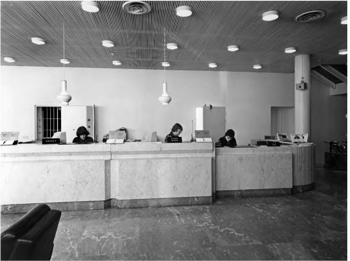
Banksalen i ursprungligt skick. Undertaket av tunna träribbor är typiskt för Alvar Aalto. Golvet av grå marmor har ett markant ådringsmönster. I fondväggen syns bankkvalvets dörr och ingången till arbetsrummen mot Ystadsgatan. Foto Ekenäs Sparbanks arkiv.
