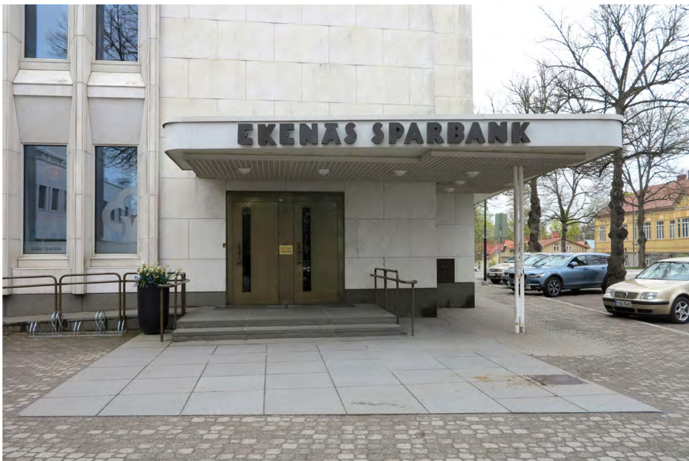
Entrépartiets baldakin verkar sväva fritt, stödd på endast en tunn stålpelare. Rampen är byggd nyligen. Foto Mona Schalin
