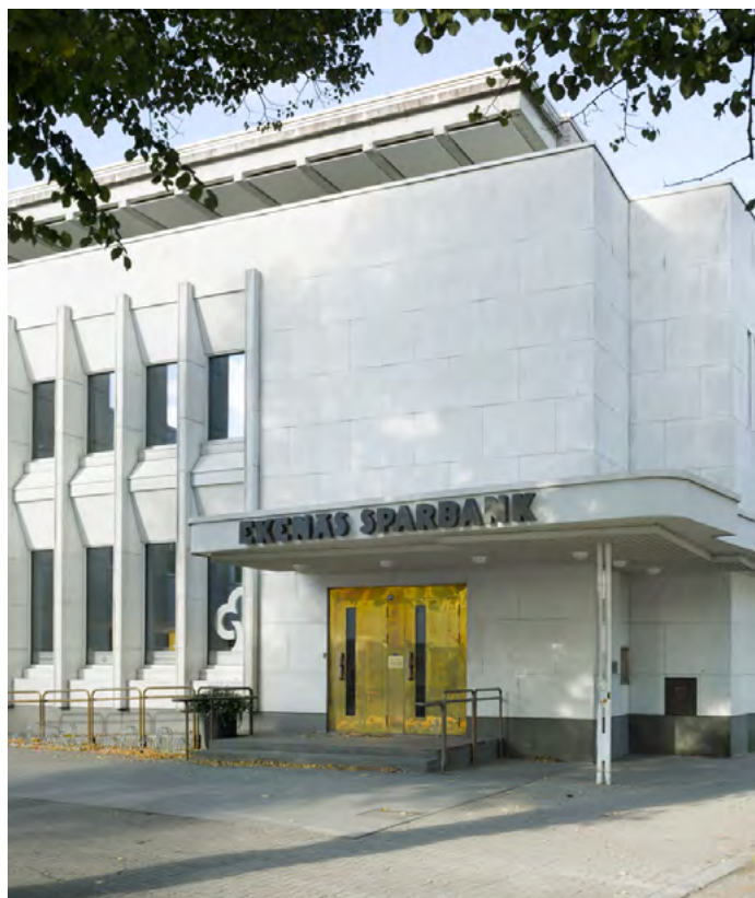
Foto av den nybyggda rampen och de förnyade dörrarna 2015, Max Plunger.
