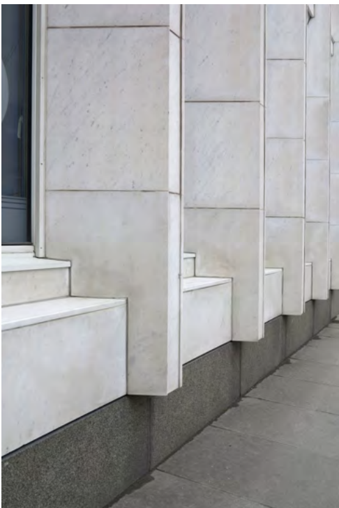
Fasadens karakteristiska material är Carraramarmor, mörkgrå granitsockel, bronshandtag i Aaltos design och huvudentréns kopparplåt. Foton Kristina Karlsson och Mona Schalin
