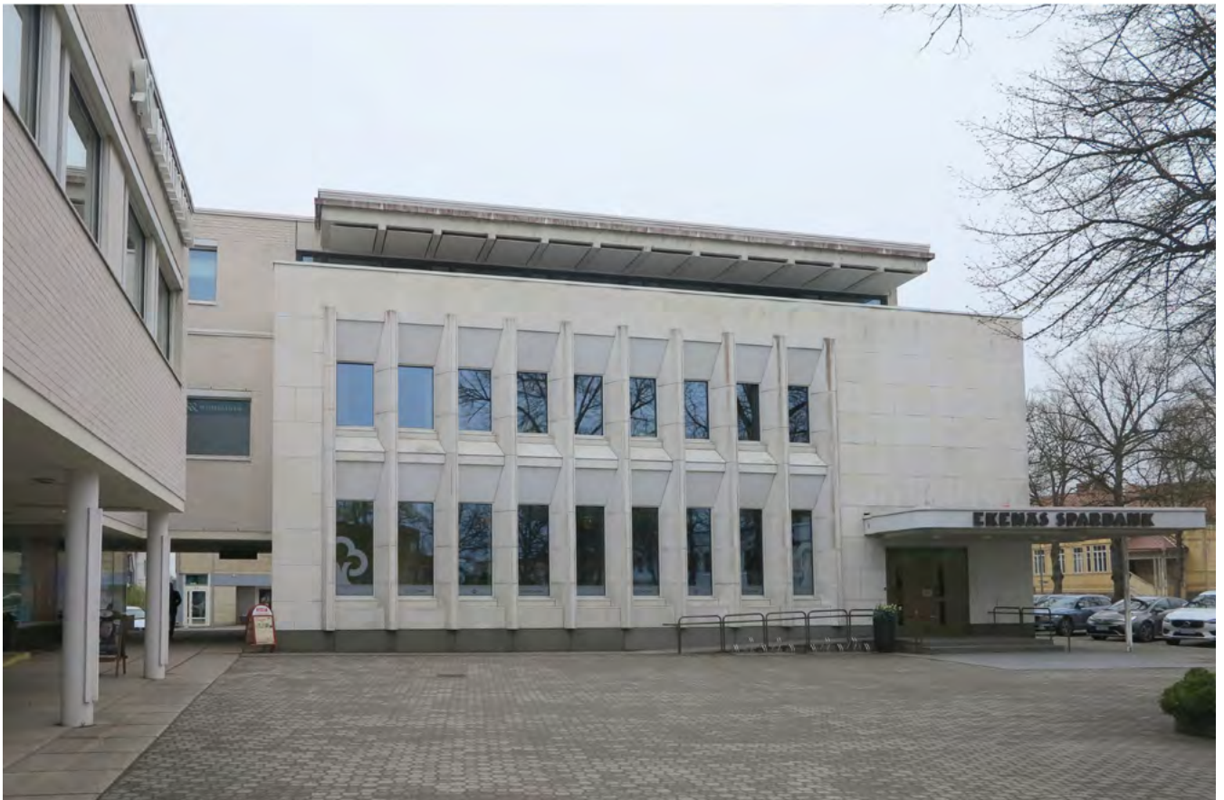
Pelargångens betongplattor övergår i den nyare betongstensbeläggningen på ett slumpartat sätt.
