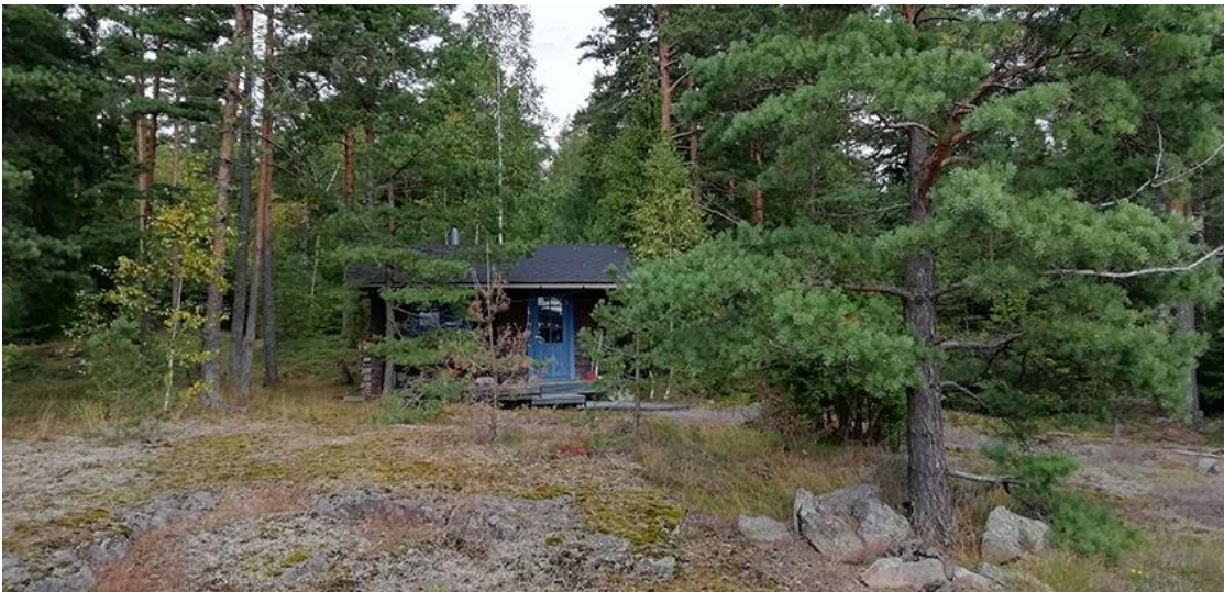
Kuva 12. Korttelin 6 rakennuspaikalla 3 oleva sauna.
